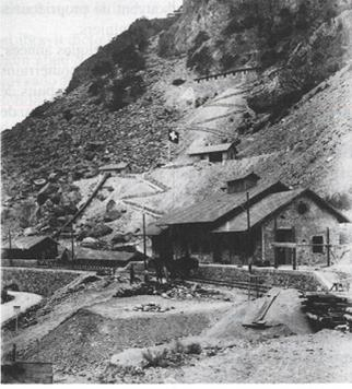
Fig. 2: Vue générale depuis l'est. Au premier plan, le quai de chargement et le local de concassage. A gauche en bas, la route du St Bernard et plus haut, derrière un petit bâtiment, la trémie pour le minerai. On remarque la couleur claire des déblais de fluorine qui contraste avec les roches plus sombres des éboulis.
